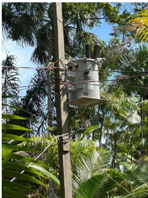
Figura 18. Linhões — linhas de distribuição informais — nas ilhas do município de Abaetetuba. FOTO: Vinícius Oliveira/IEMA
