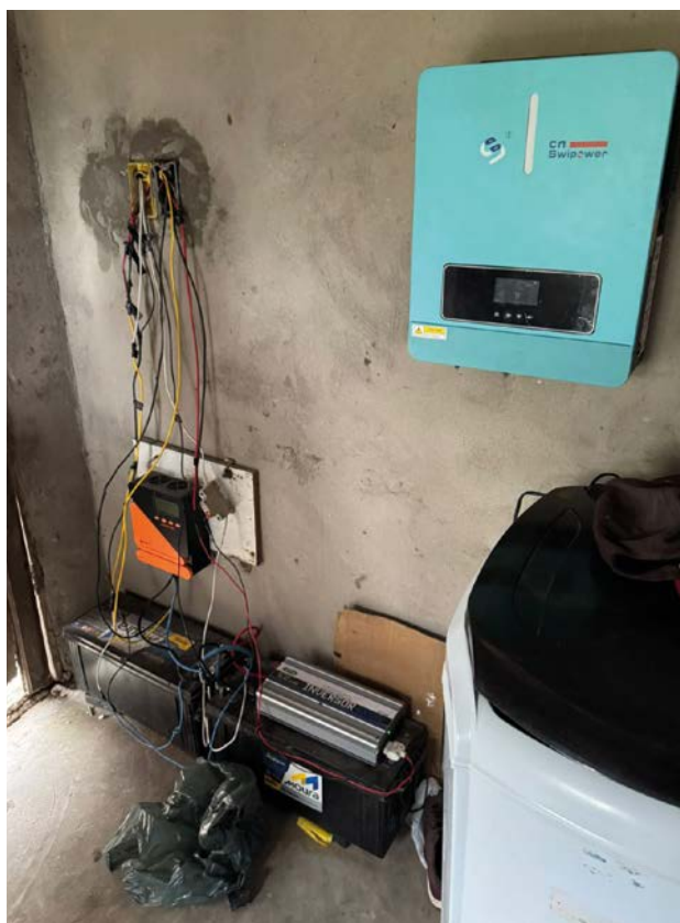
Figura 19. Sistema residencial implementado sem padrão de segurança, com inversor em desuso e baterias de chumbo-ácido.
